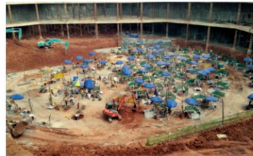
T1塔桩基施工现场图
